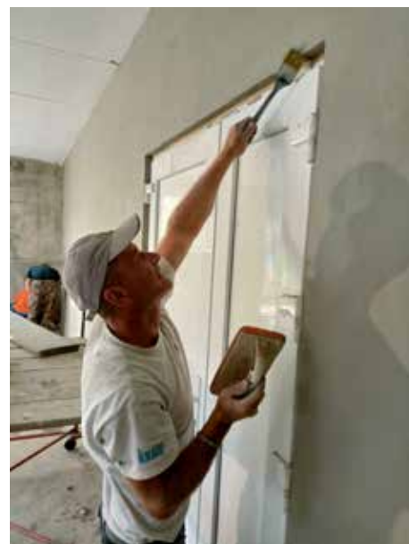
Omítání v nové posilovně
