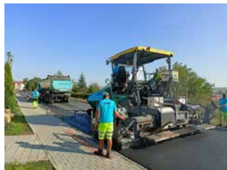
Rekonstrukce hl. silnice v ul. Chřib
