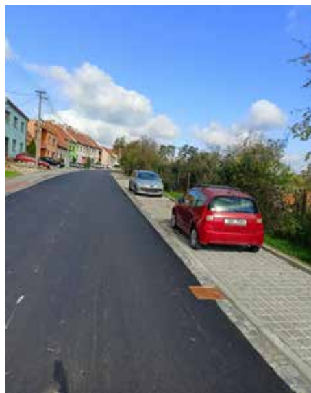
Nová podélná stání a ul. vpusti v ul. Chřib
