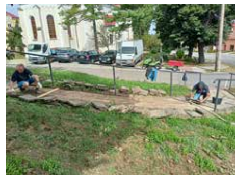
Oprava chodníku na hřbitov
