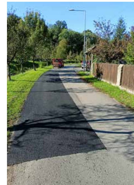
Oprava MK ul. Chřib u ČOV
