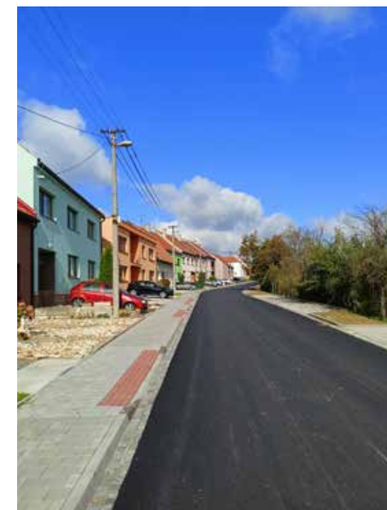
Rekonstrukce chodníku, nové podélné stání v ul. Chřib
