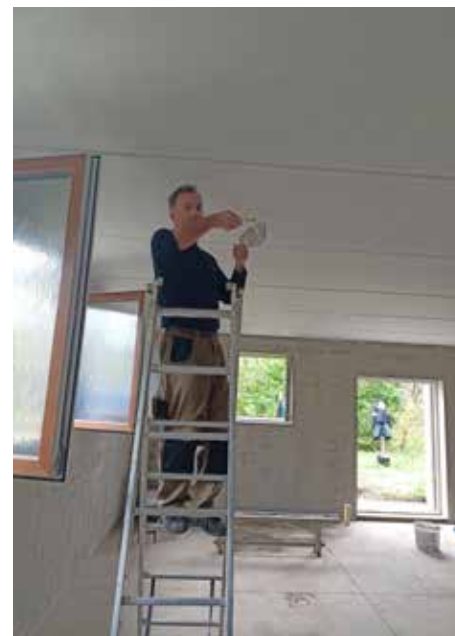
Spárování mezi stropními panely v nové posilovně
