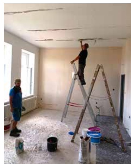
WC chlapců v ZŠ při rekonstrukci
