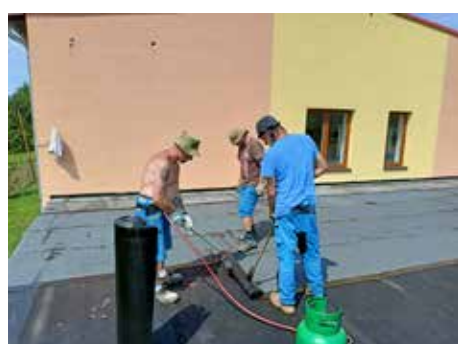
Hydroizolace stropu posilovny
